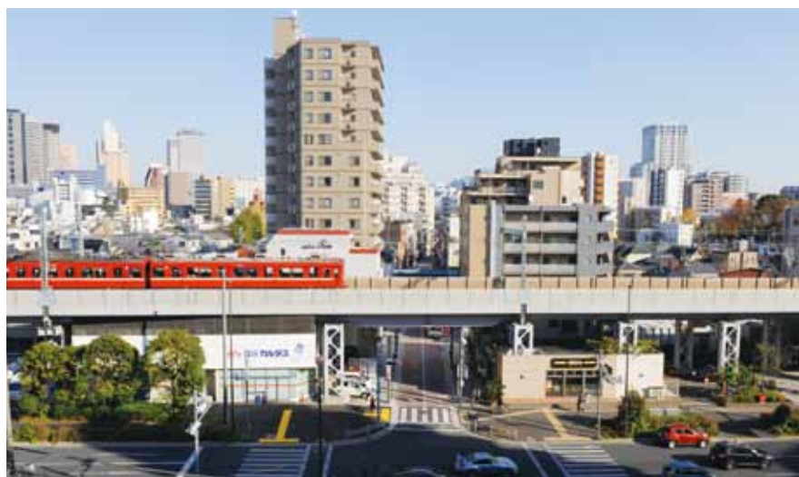
高架になった京急本線と街並み（平成24年（2012）12月撮影）
