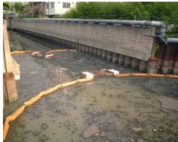
降雨直後の河口付近の様子
