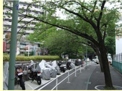
周囲との調和が図られていない立会道路
