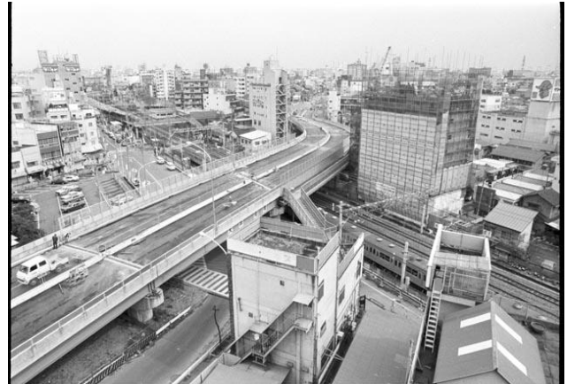
補助28号線（大井陸橋）昭和57年
