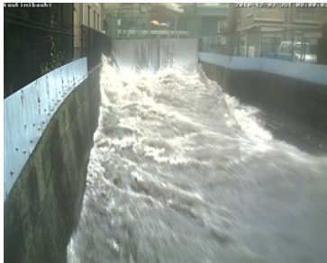
雨天時の未処理下水の放流状況
