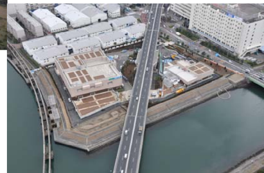
水質改善に寄与する整備中の勝島ポンプ所
