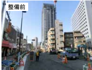
補助 163 号線の整備前後の様子
