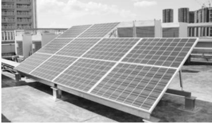
区では、第二庁舎屋上で太陽光発電を行い、3階フロアの照明の電力補充に利用しています。さらに太陽光パネルを増やし、7月30日(金)から来庁者に電動自転車充電サービスを始めました。また、発電量を第二庁舎3階に表示し、二酸化炭素排出削減の啓発にも役立っています。
