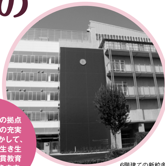
6階建ての新校舎
