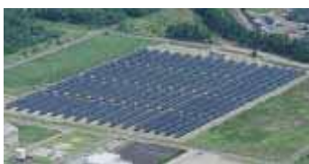
昭和シェル石油(株) 雪国型メガソーラー発電所
