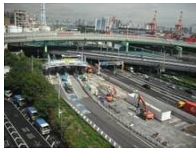
品川清掃工場 6 階から見た湾岸の景色
