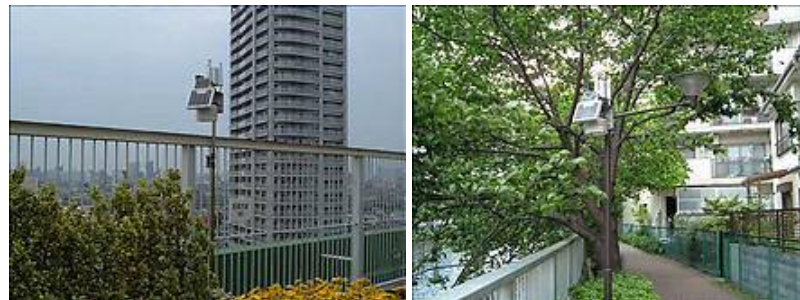
庁舎屋上計測器／目黒川護岸計測器
