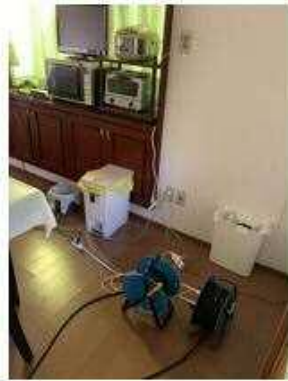
←ダイニングに引き込んだ 蓄電池系統と太陽光 発電自立運転系統の2つの ドラムコードリール
